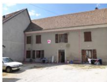
Façade Sud - Logement A - T3 environ 85 m²
