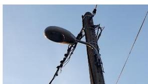
Le remplacement des têtes de lampadaires a continué. Les nouvelles têtes de lampadaires utilisent des ampoules consommant moins d'énergie (seulement 60 W, c'est un progrès très net par rapport aux ampoules d'il y a quelques années). Elles sont étudiées pour mieux éclairer le sol, et moins diffuser de lumière gênante vers le ciel.
