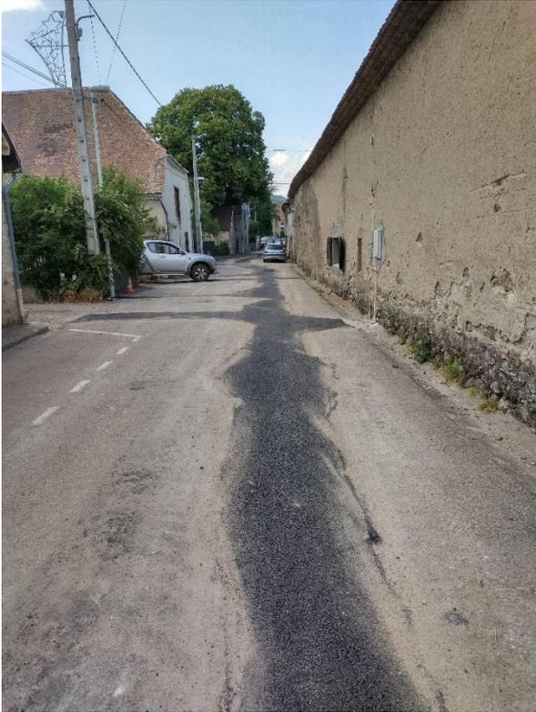
Les enfouissements de câbles électriques et les raccordements aux domiciles sont terminés, ceux de télécommunications suivront au mois d'août, puis les anciens câbles et poteaux seront déposés.
